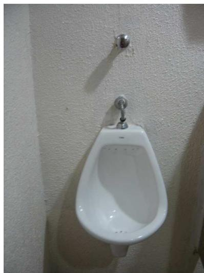
Equipamentos hidráulicos com reguladores de vazão.
