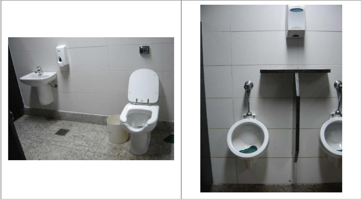
Equipamentos hidráulicos com reguladores de vazão.
